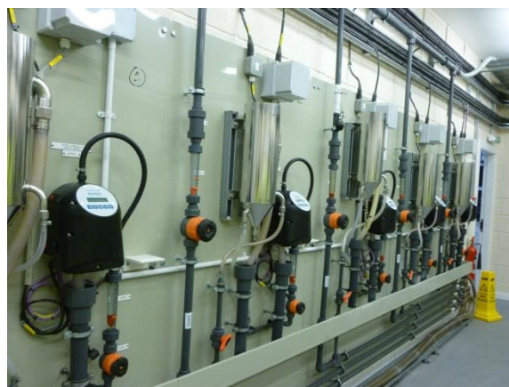
Aviemore WTW Monitors
